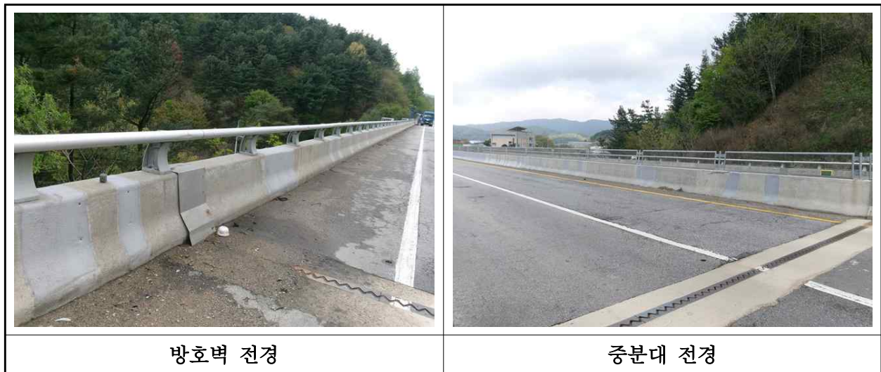
【사진 8.3.23】 방호벽 및 중앙분리대 전경
