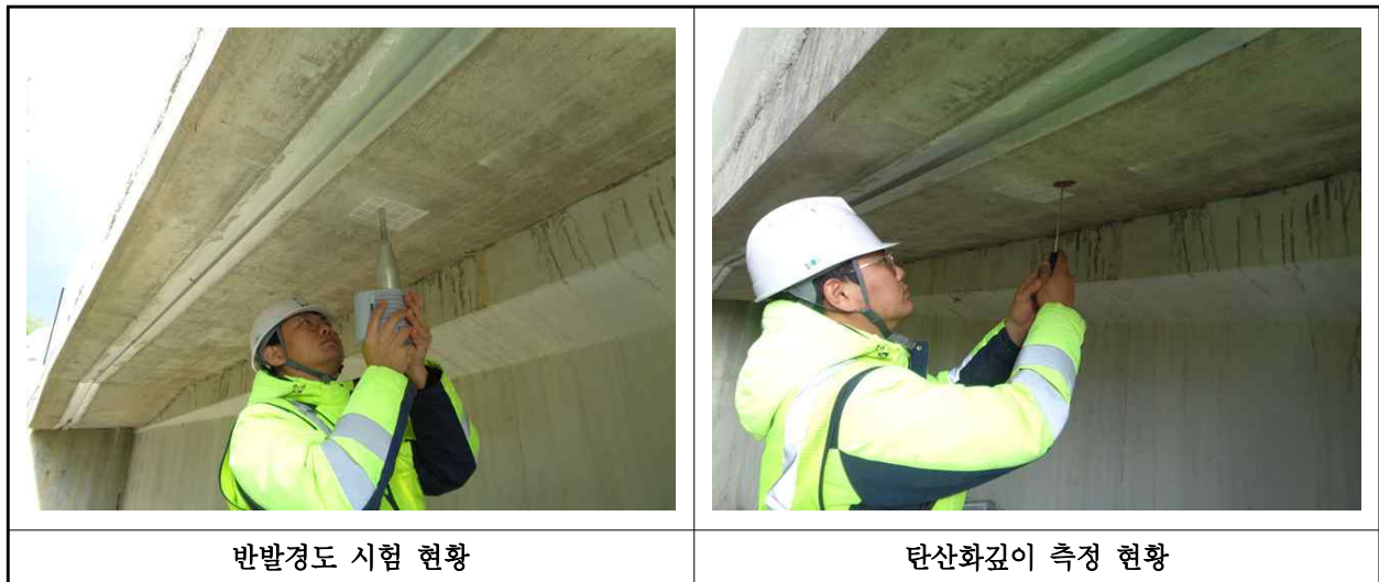
【사진 8.4.1】 콘크리트 내구성조사 현황
