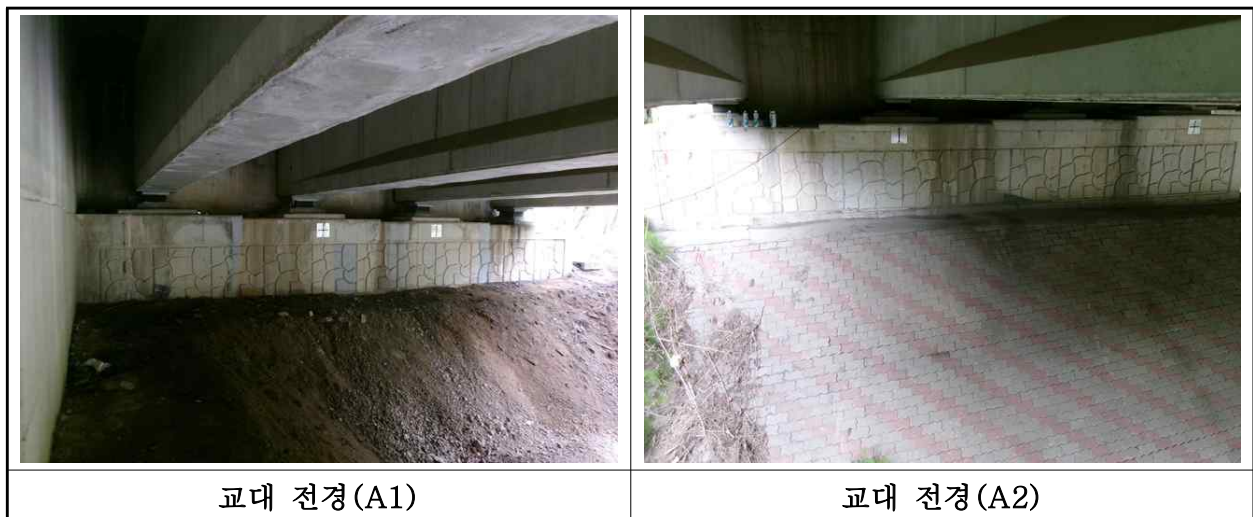
【사진 8.3.8】 교대 전경
