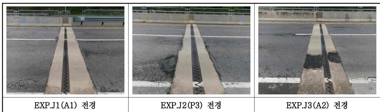
【사진 8.3.16】 신축이음장치 전경
