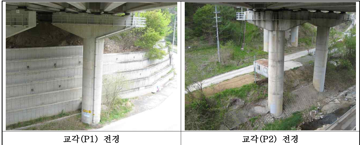
【사진 8.3.10】 교각 전경
