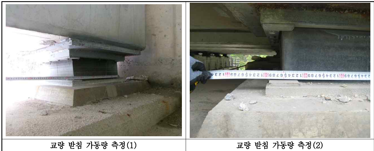
【사진 8.3.15】 교량받침 이동량 측정
