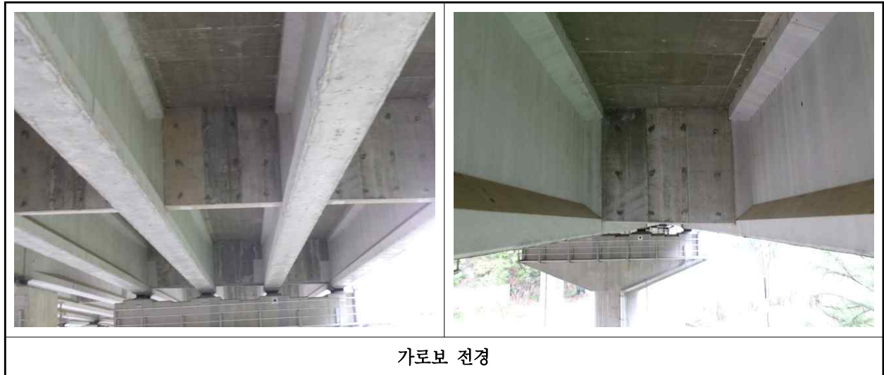
【사진 8.3.6】 가로보 전경
