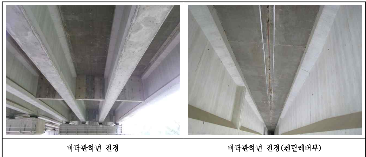
【사진 8.3.2】 바닥판하면 전경
