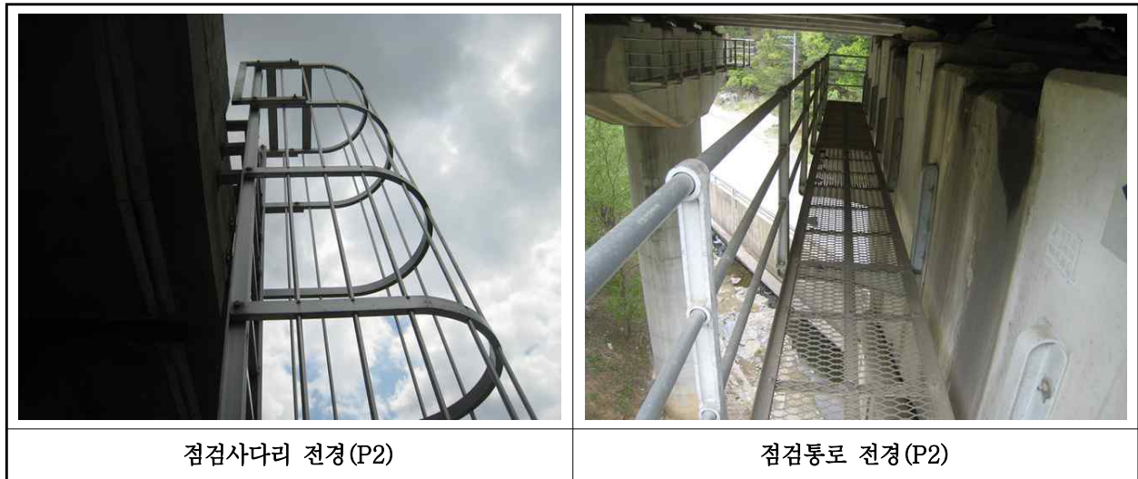
【사진 8.3.25】 교량 점검시설 전경
