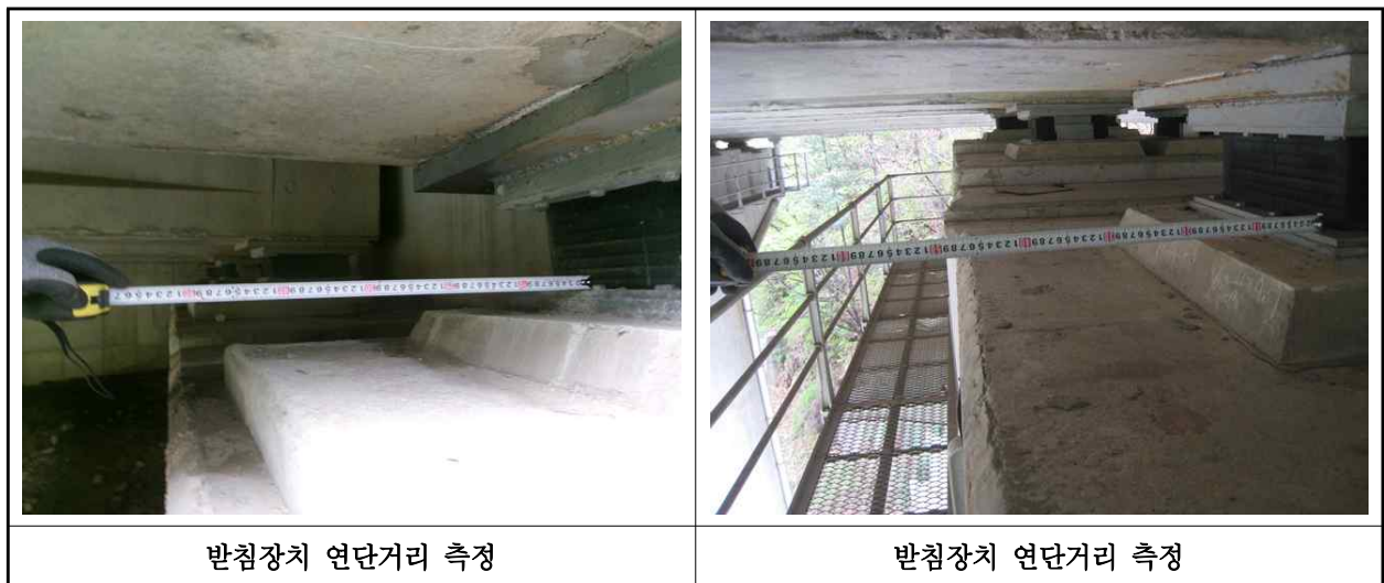
【사진 8.3.14】 교량받침장치 연단거리측정
