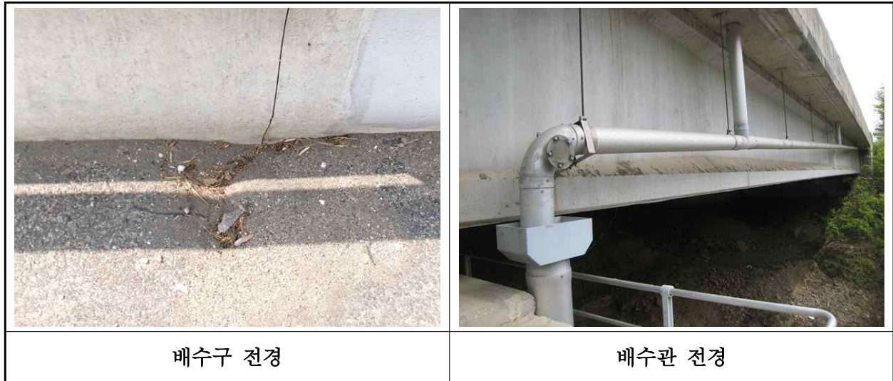
【사진 8.3.21】 배수시설 전경
