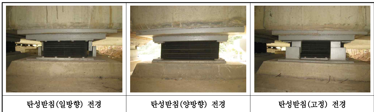
【사진 8.3.12】 교량받침 전경
